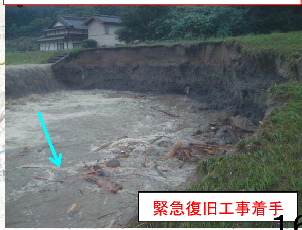
彦山川 左岸 31k500付近 堤防欠損
