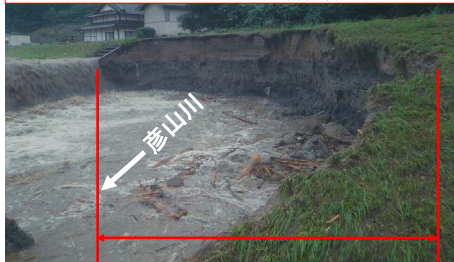
堤防欠損 L=30m
