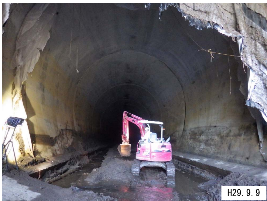
仮排水路トンネル吐口（下流側）の堆積土砂撤去状況
