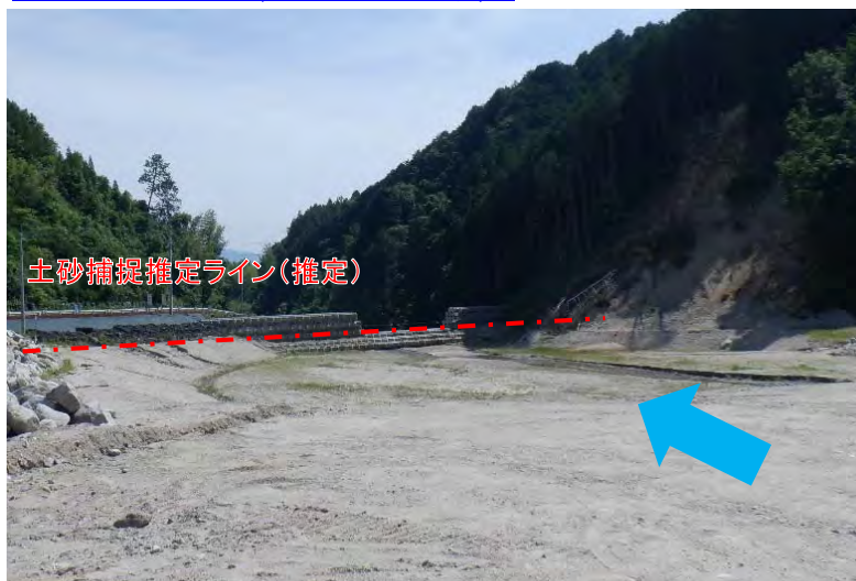
土砂捕捉前 (R2.6.2撮影)
