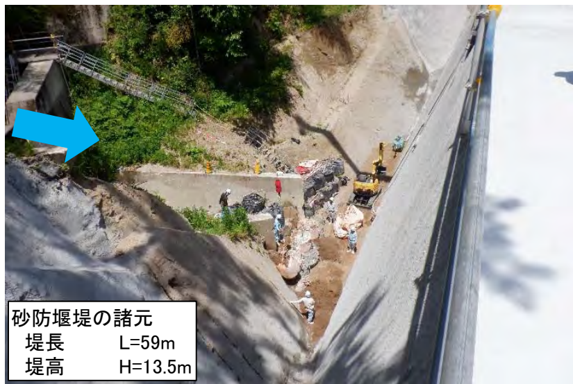
土砂捕捉前 (R2. 6. 2撮影)
