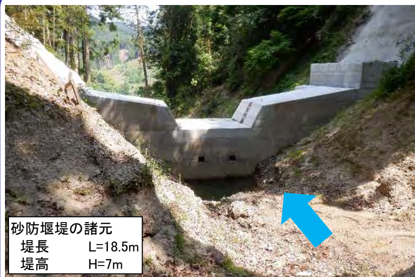
土砂捕捉前 (R2. 5. 28撮影)
