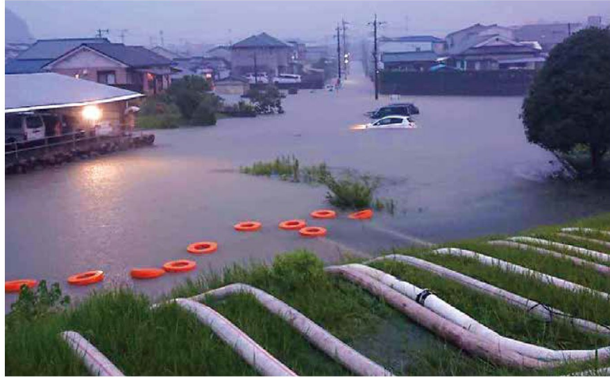
さつま町虎居樋門付近 内水による被害状況
