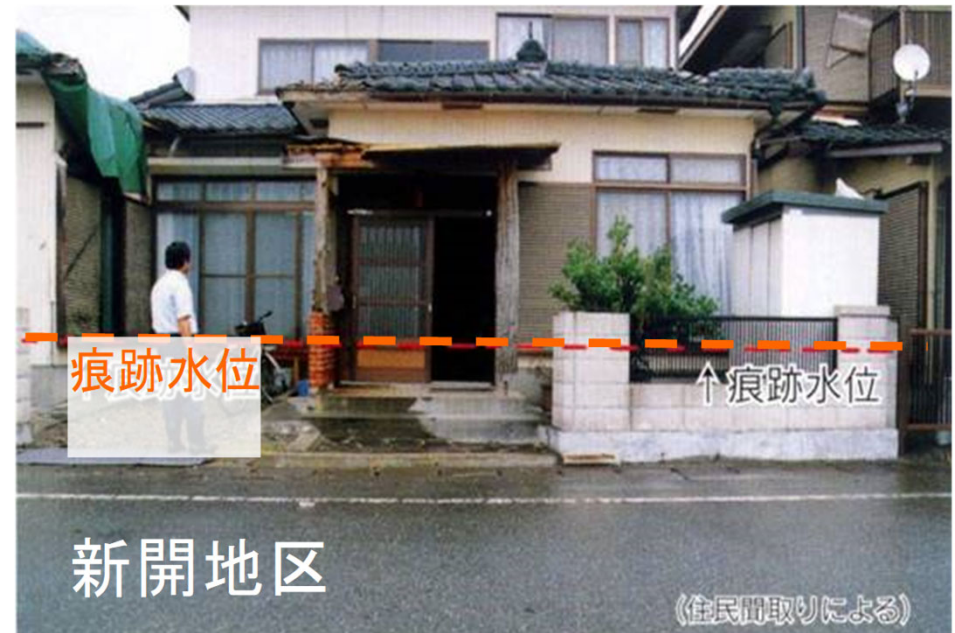
しんかい 新開地区浸水状況 (八代市新開町) (住民間取りによる)
