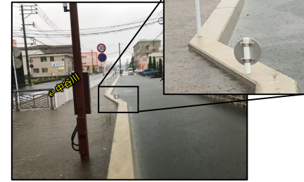
【写真②】中谷川護岸嵩上げ
