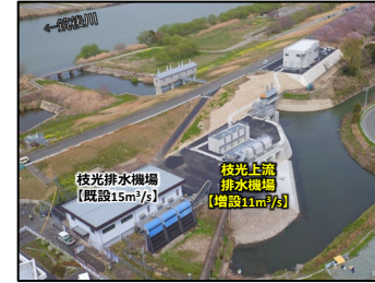
【写真①】枝光排水機場のポンプ増設
