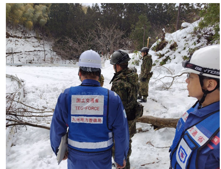
▲ 自衛隊と連携した被災状況調査
