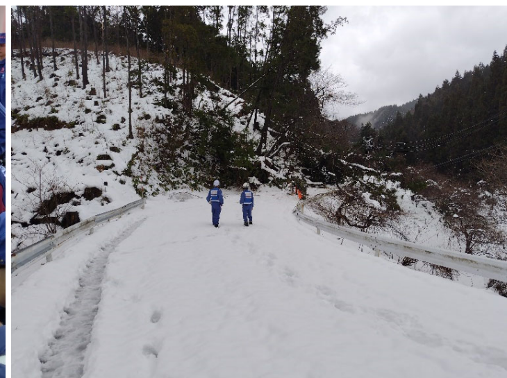
▲ 道路の通行可能調査
