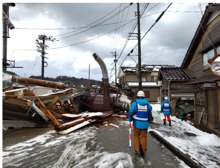
▲ 道路の被災状況調査
