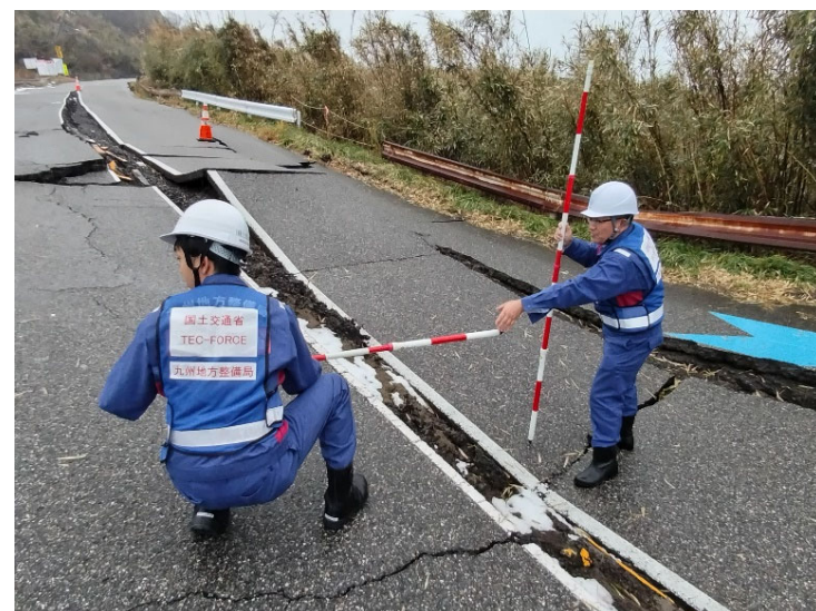
▲ 道路の被災状況調査
