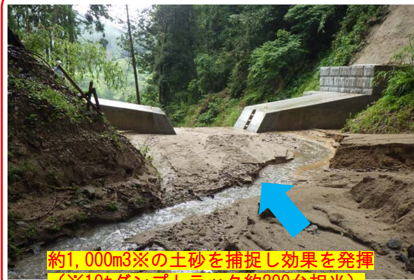
土砂捕捉後 (R2. 7. 8撮影)
