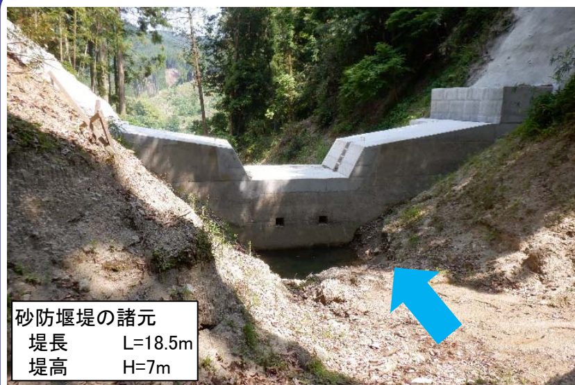
土砂捕捉前 (R2. 5. 28撮影)
