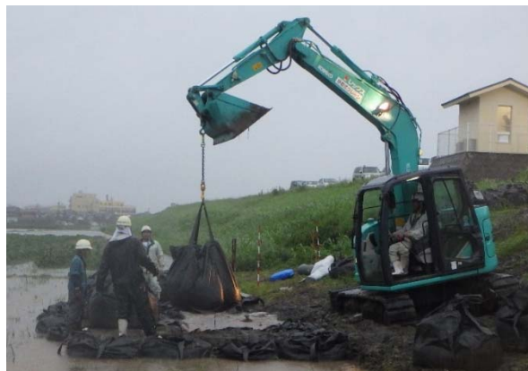
応急対策状況
