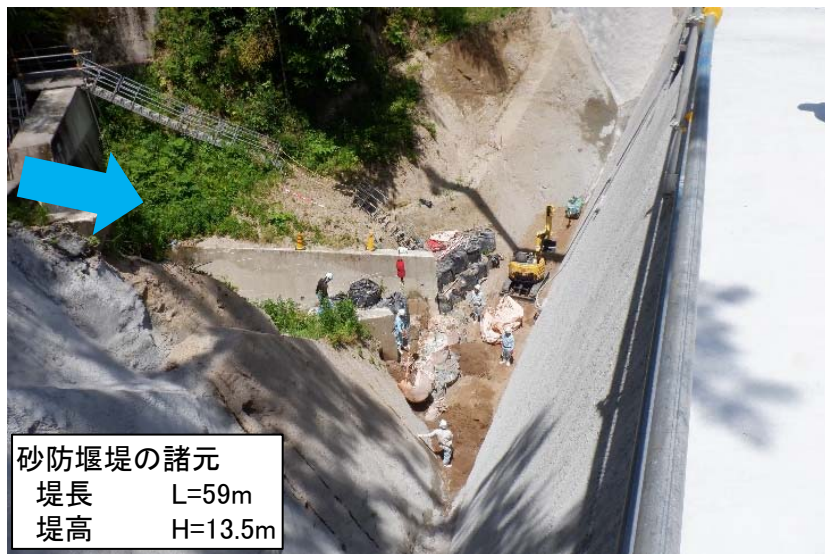
土砂捕捉前 (R2. 6. 2撮影)
