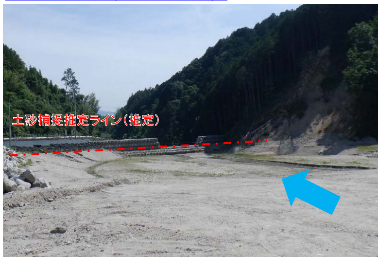
土砂捕捉前 (R2.6.2撮影)
