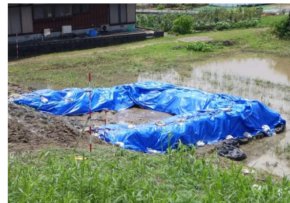
応急対策状況
