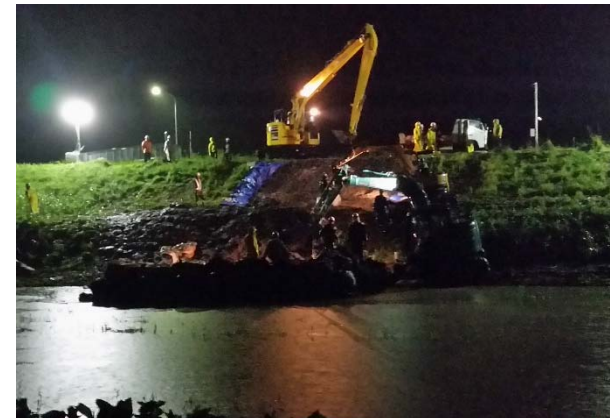
応急対策状況
