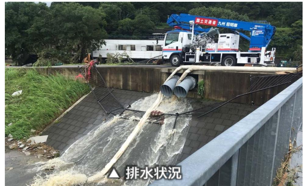
○福岡県大牟田市の浸水箇所において、7月7日（火）排水ポンプ車を設置し排水作業を実施。
