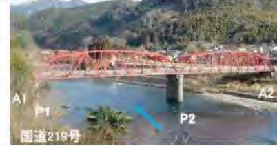
被災前の状況(平成15年 3月時点)
