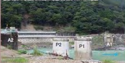
被災後の状況(上部正流失状況 A1~A2間)
