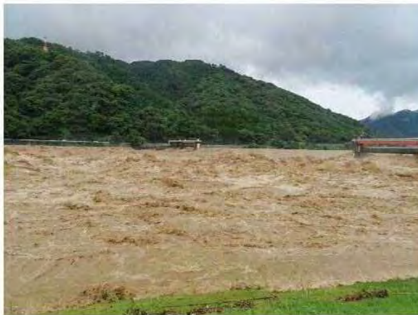
頭首工 下流側から
