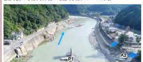
被災後の状況(上部工流失状況 A1~A2間)
