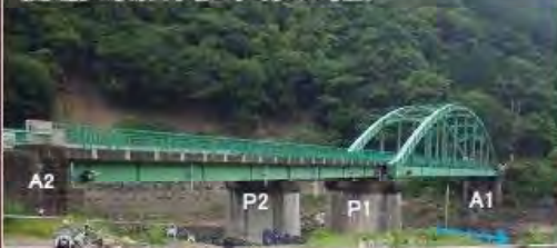
被災前の状況(令和2年6月3日時点)
