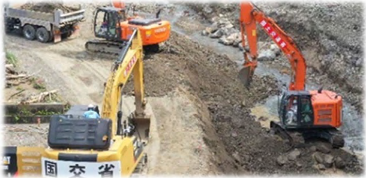
(河川 堆積土砂の掘削状況)
