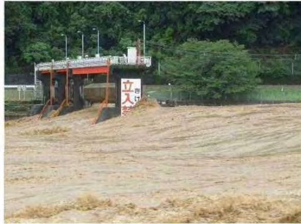
右岸側(土砂吐・洪水吐)
