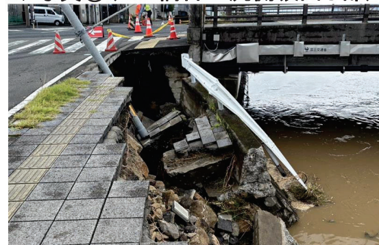
◆写真①(A1橋台上流側吸出し部)
