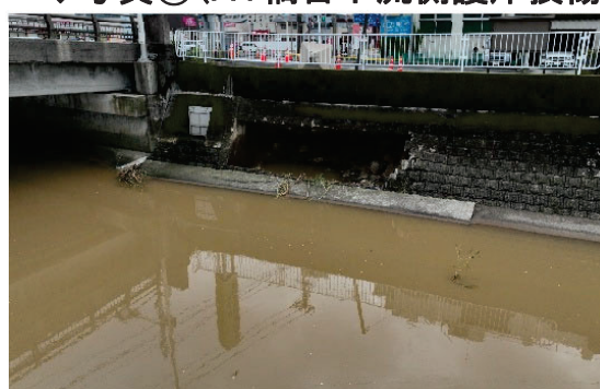
◆写真②(A1橋台下流側護岸損傷)
