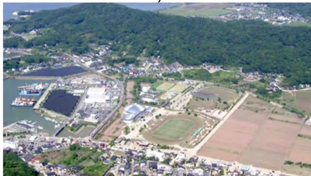
上天草市松島町 合津川 浸水状況
