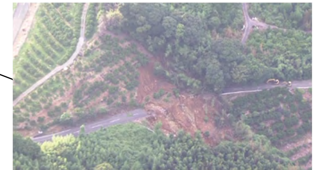
宇城市不知火町松合 土砂崩れ
