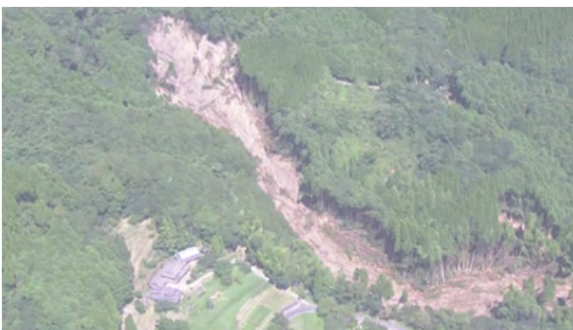
天草市栖本町 土砂崩れ
