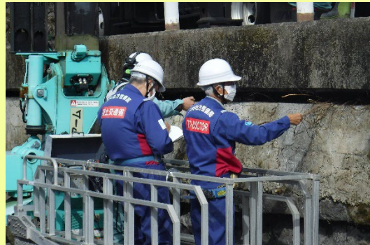
現地点検状況
