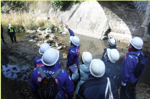
点検事前説明状況
