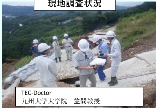
現地調査状況
