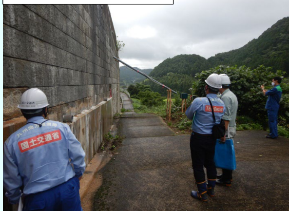
現地調査状況(大舟地区)
