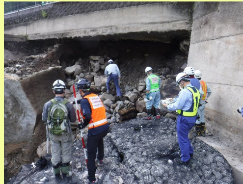
現地調査状況
