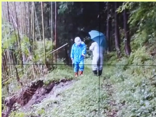
現地調査状況 (被災直後)
