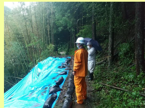
現地調査状況 (応急対策後)
