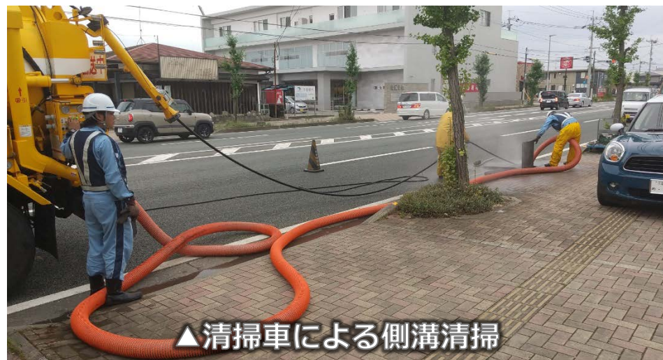
▲清掃車による側溝清掃
