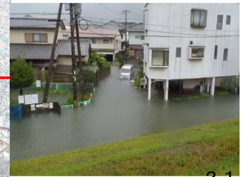
七瀬川右岸光吉地区浸水状況(9月17日)
