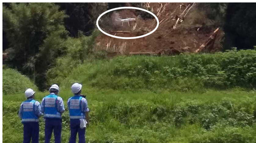
▲ドローンによる調査状況
