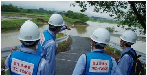
▲ 河川堤防の被災調査
