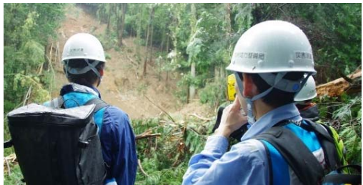
▲ 砂防の被災調査
