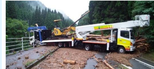
▲ 道路の啓開作業
