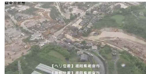
▲ 防災ヘリからの被災調査
