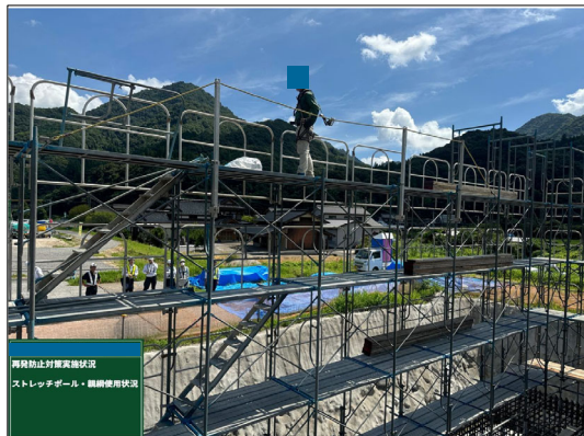
足場組立(解体)時は、ストレッチポールを使用し親綱を設置する。
