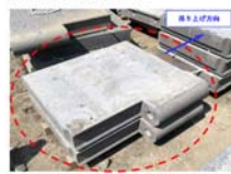
壁面材吊り具の構造
