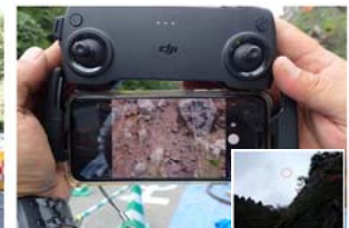
・ドローンによる点検状況
