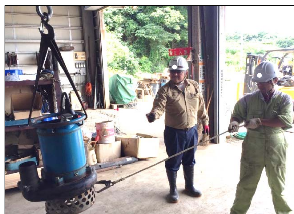
適切なクレーン計画と荷振れ防止の介錯ロープ使用の徹底
