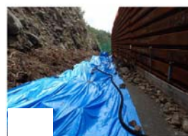
・作業終了後のブルーシート設置状況
