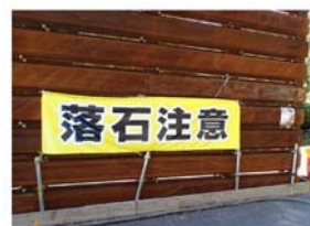
・仮設防護柵に注意喚起を掲示状況
