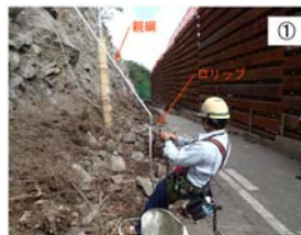
ロリップを装着し、安全確認のため、親綱の点検（たるみを取る）を行った。
