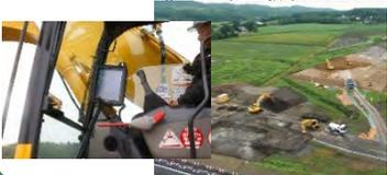
3次元設計データ等により、ICT建設機械を自動制御し、建設現場のICT化を実現。
