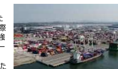
▲国際物流ターミナルの整備による国際船舶 貨物輸出入を強化する取組 【博多港 アイランドシフトコンテナターミナル】
