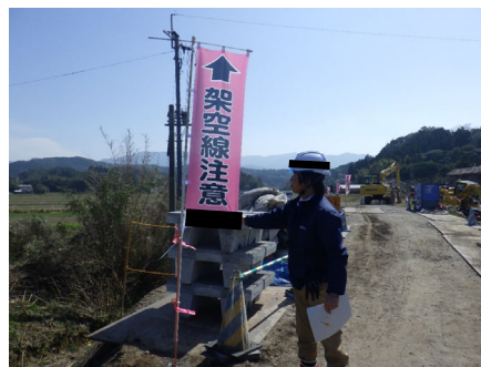
注意喚起ののぼり旗を現場周辺に設置し、安全確認の気づきを高める。
