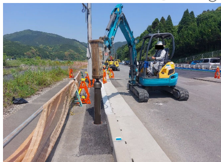
ガードパイプ支柱建て込み状況
