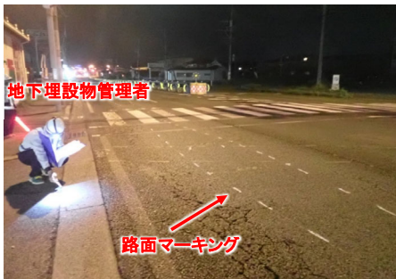
地下埋設物路面マーキング 地下埋設物管理者の配置
