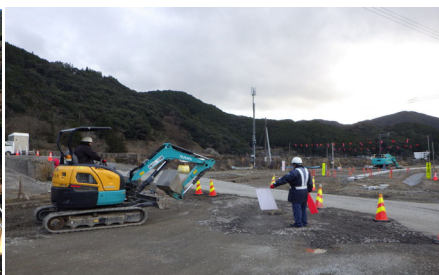
バックホウ移動時に見張り員を配置
