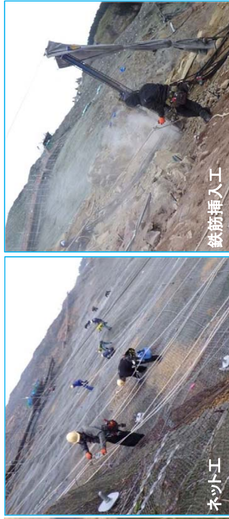
・植生マット工、ネット工・鉄筋挿入工 施工中
