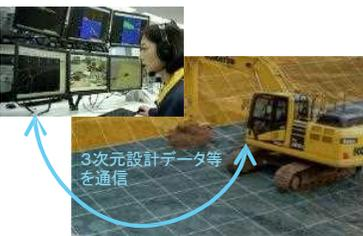
3次元設計データ等により、ICT建設機械を自動制御し、建設現場のIoT(\*)を実施。
