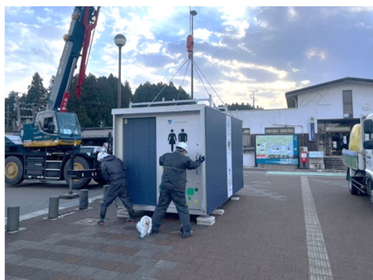
コンテナ型トイレ設置(穴水町)
