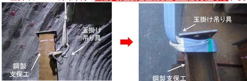
・合図者の合図で、吊荷を地面から30cm上げた箇所で、吊荷から3m離れた場所で、3秒間静止状態を確認し、建て込み作業を実施する。(地切り:玉掛け作業の3・3・3運動)
