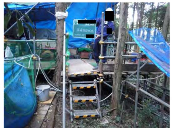
手すりや昇降設備等を設置し転倒及び落下防止を図り、また、開口部を無くし作業空間を設けることで作業員の安全を確保する(図中の赤)。
