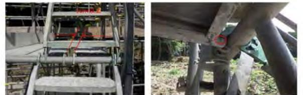
① 監理技術者が安全巡視を行った結果、床板隙間が3cm以上ある事を確認する事とした。(床板の移動)
