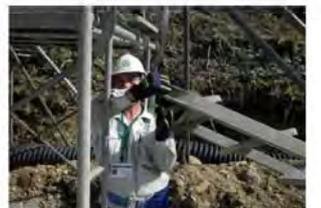
⑤ 階段下側を変えていた監理技術者が右側のフックも外れたと思い持ち上げる。その反動で、右側フックが外れ先に外れていた左側フック部が落下する。
