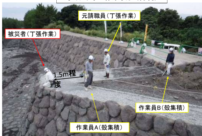
事故当時の作業状況(再現)
