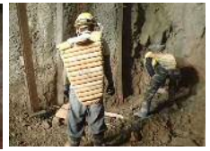
③当たり取り(脚部)確認、根掘り、血板敷作業
