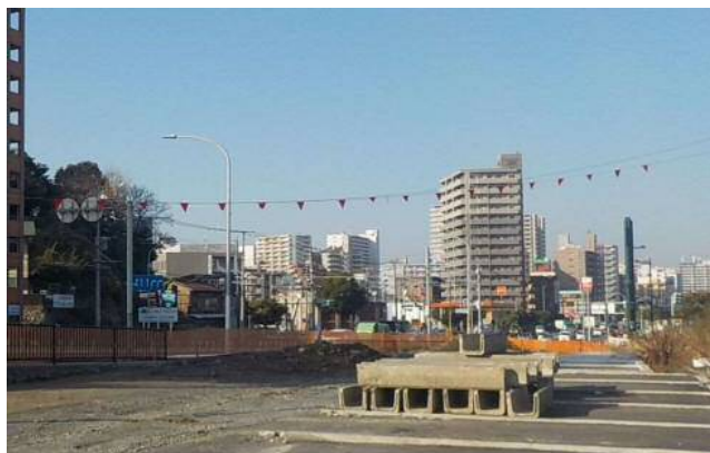
架空線等の接触・切断事故防止対策 (三角旗)
