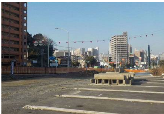
架空線等の接触・切断事故防止対策 (三角旗)
