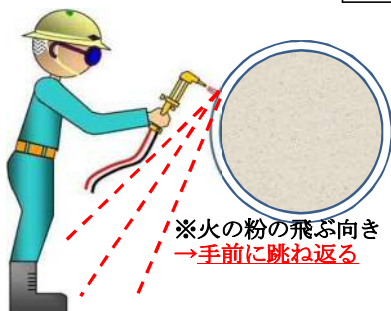
図-1 切断箇所拡大（事故箇所）
