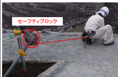
セーフティブロック設置による墜落防止
