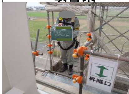
②昇降口にクランプカバーを取り付ける
