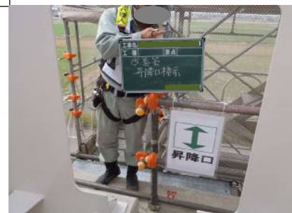
③昇降部分に注意喚起を取り付ける
