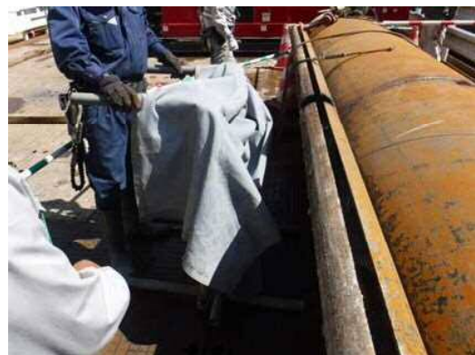
写真-2 防護柵設置状況
