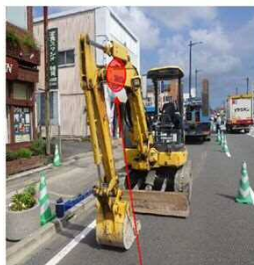
接触箇所 (バックホウの左側アーム)
