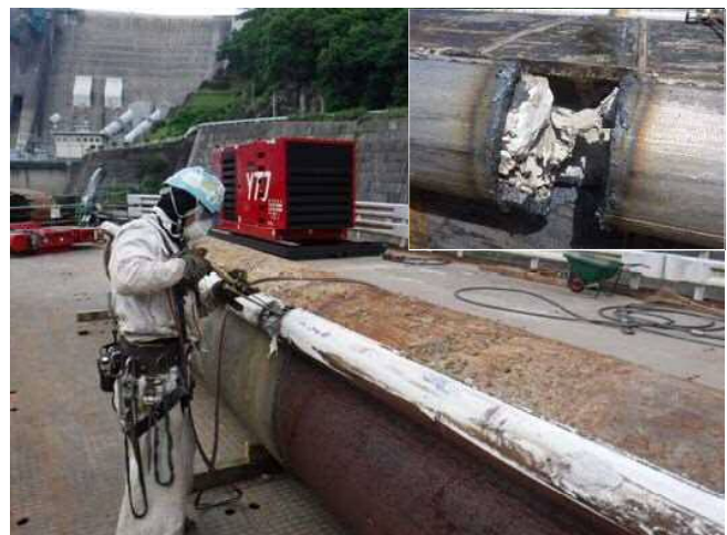
写真-1 事故発生時の作業状況(再現写真)
