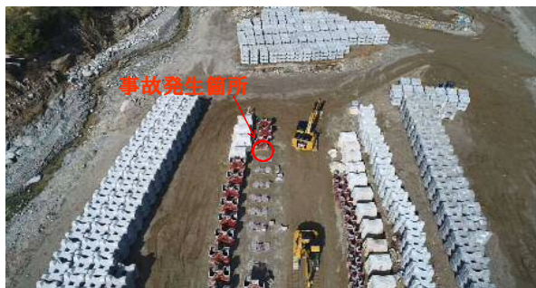
【根固めブロック製作ヤード】
