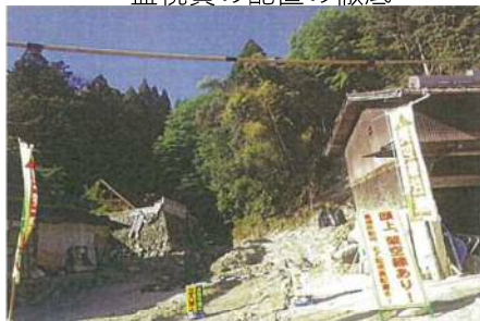
注意喚起の視認性の向上と架空線横断部に防護カバーを設置
