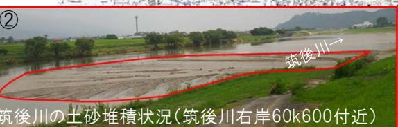
②筑後川の土砂堆積状況(筑後川右岸60k600付近)
