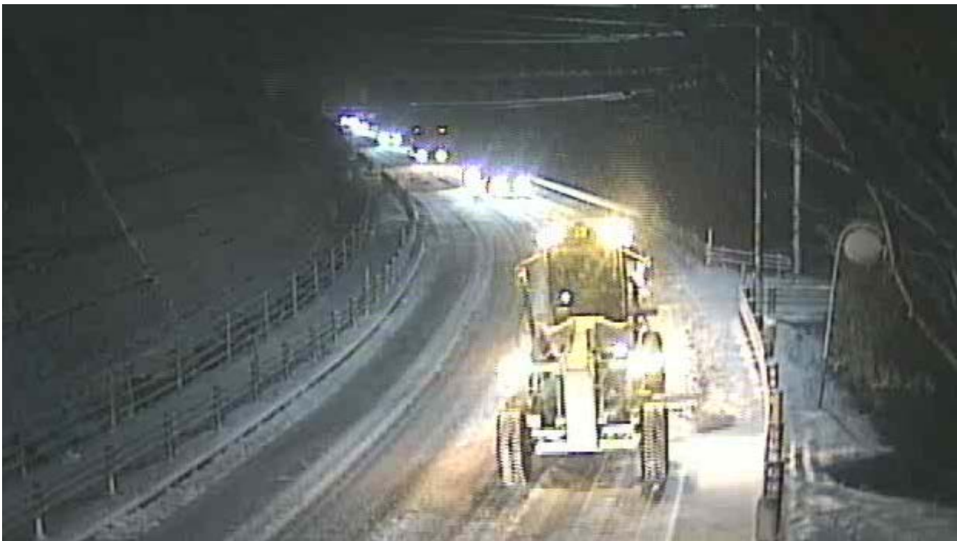
平成29年1月20日～ 国道210号における除雪状況
