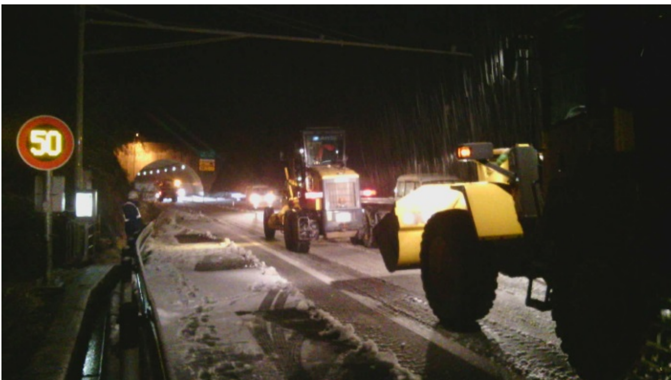
平成29年2月10日～ E3A南九州西回り自動車道における除雪状況
