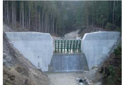
流木捕捉効果の高い透過型砂防堰堤イメージ
