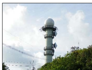
八本木山レーダ雨量観測所 （長崎県五島市）
