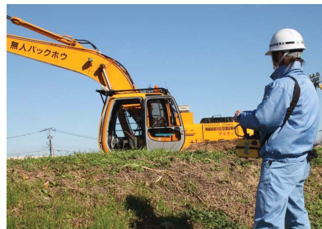
遠隔操縦式バックホウ操作状況
