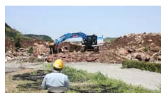
遠隔操縦専用機による復旧作業（熊本県阿蘇大橋地区）
