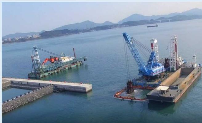
工事着工状況（岸壁前面の床掘）
