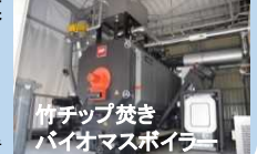
竹チップ焼きバイオマスボイラー
