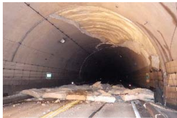
断層変位による損傷状況
