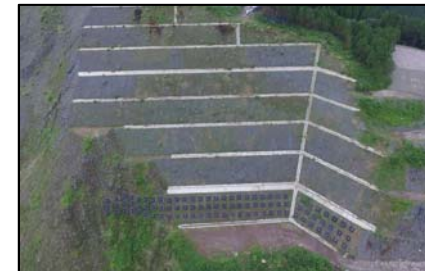
大分側凸部 排土工
