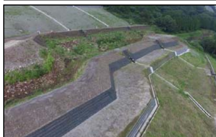
土留盛土工(山側ポケット)、 谷側風化防止工(鋼製土留)
