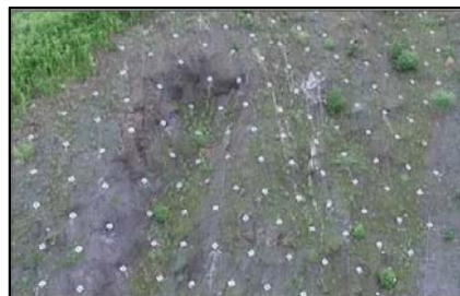
斜面上部 高強度ネット工+鉄筋挿入工
