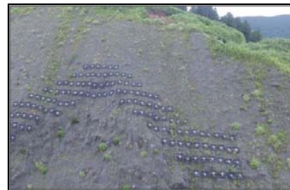
斜面上部 鉄筋挿入工+パネル
