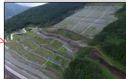
中腹～下部 山腹工(鋼製土留)、水路工
