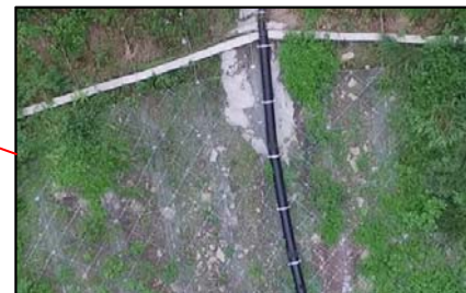
大分側ガリ— 高強度ネット工+鉄筋挿入工,ロープ伏工
