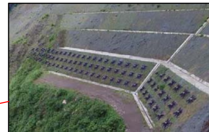
大分側凸部 アンカー工+受圧板工
