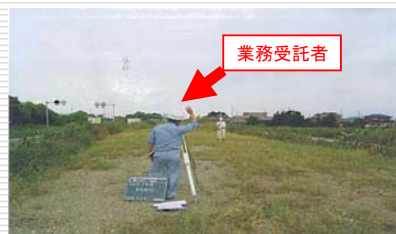
(現場状況の照合を実施)
