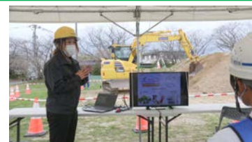
ICT建機による操作体験
