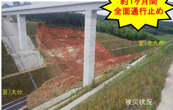
切土のり面崩落 約8,000m<sup>3</sup>
