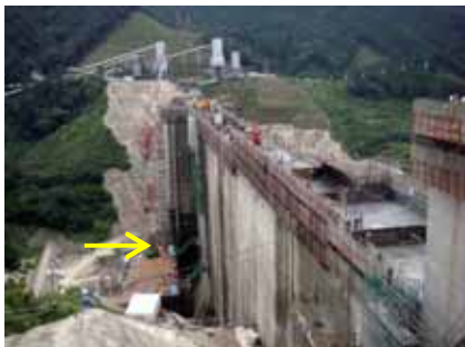
平成21年9月 本体工事中
