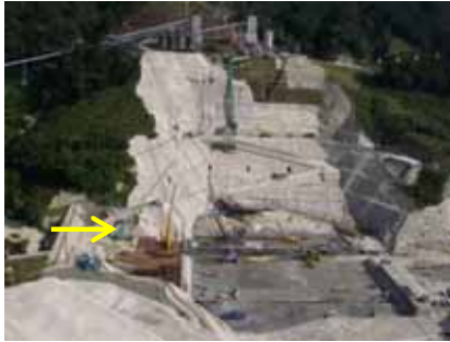
平成19年10月 コンクリート打設開始
