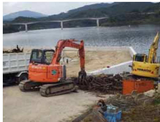
流木捕捉状況
