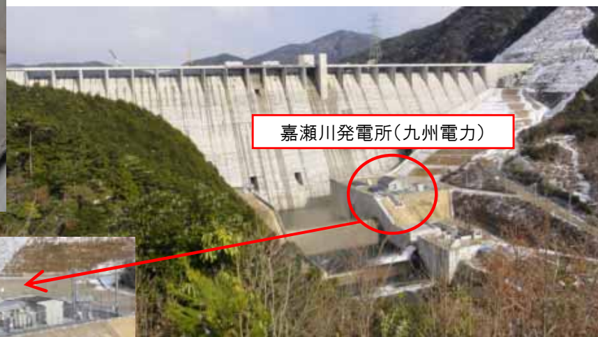
嘉瀬川発電所(九州電力)
