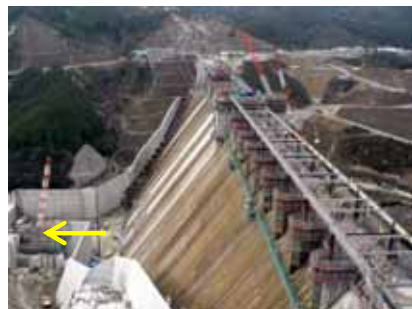
平成21年12月 本体コンクリート打設完了時
