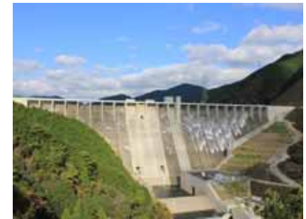
平成23年11月 試験湛水（非常用洪水吐越流）
