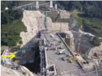
平成20年10月 本体工事中
