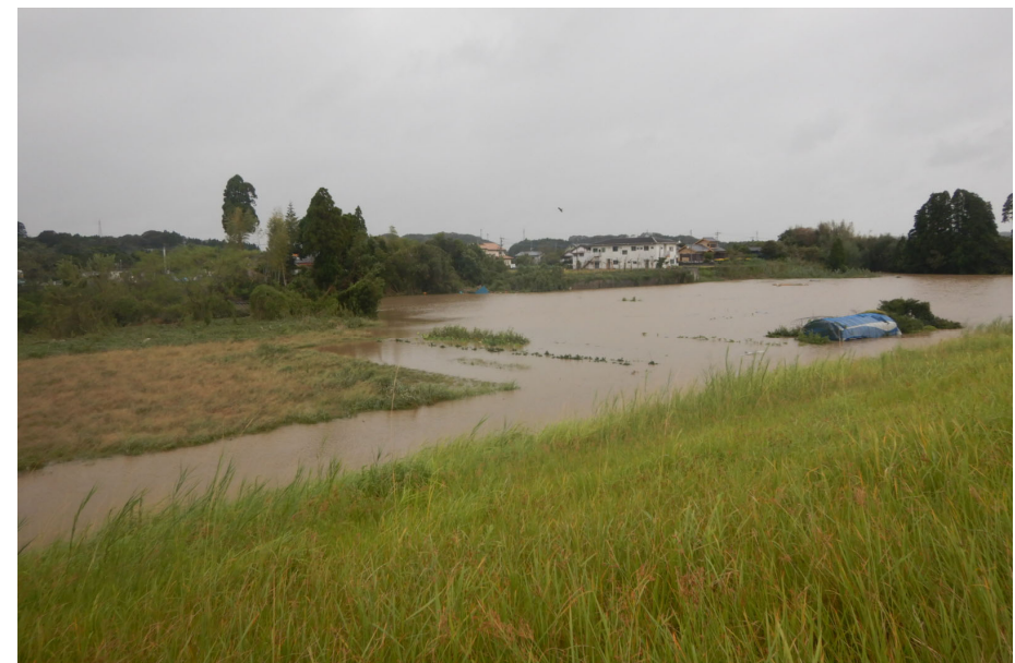
大淀川左岸15k400付近 堤内側を望む (9月19日10:00頃)
