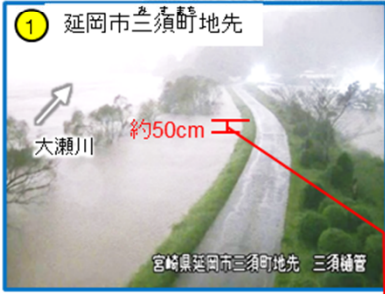
堤防天端まで約50cmの水位を記録
