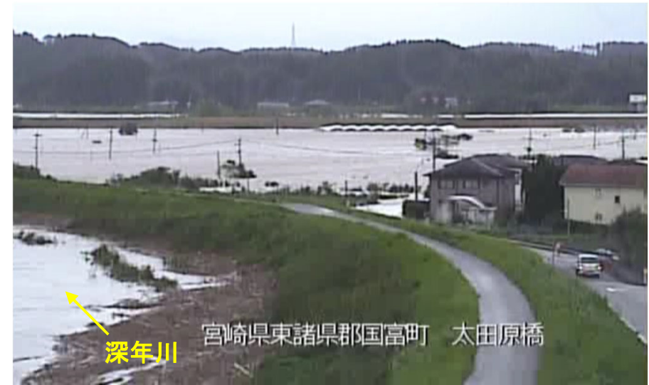
深年川右岸1k200付近 内水被害状況 (9月19日06:00頃)
