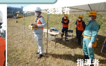
遠隔操縦式バックホウ操作 (直接目視方式)
