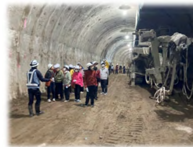
【 施工中のトンネルの現場を見学 】
