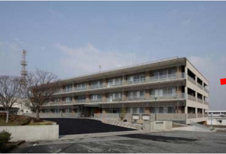
筑後川河川事務所
