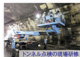
トンネル点検の現場研修
