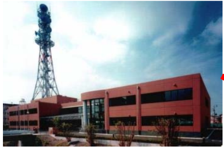
宮崎河川国道事務所
